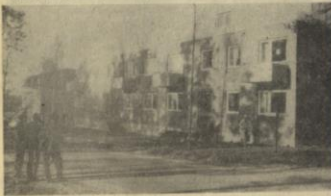
Bröderna Ström och Lennart Björklands nybygge i samhället har dagarna blivit fullföljningsklara. Bygget har med sina 33x12 m, vara Nordmalings största. För värmarö en mål, har man där fått sex bostadslägenheter, lokaler för sjukhusen, televerket samt en tandläkarpraktik.
